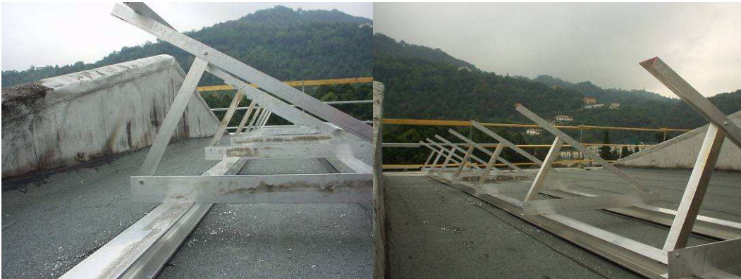
Esempio di struttura a cavalletto triangolare in alluminio anodizzato (nostre)
