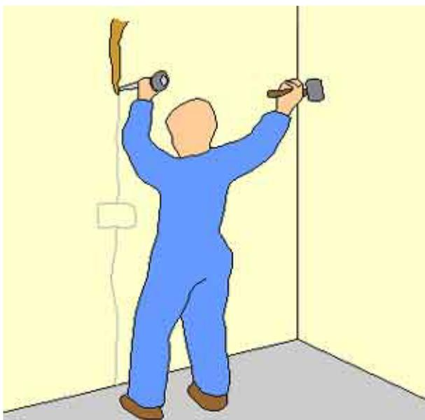
**Fig.1.2:** Si praticano le scanalature sulla parete seguendo le tracce dell'impianto
