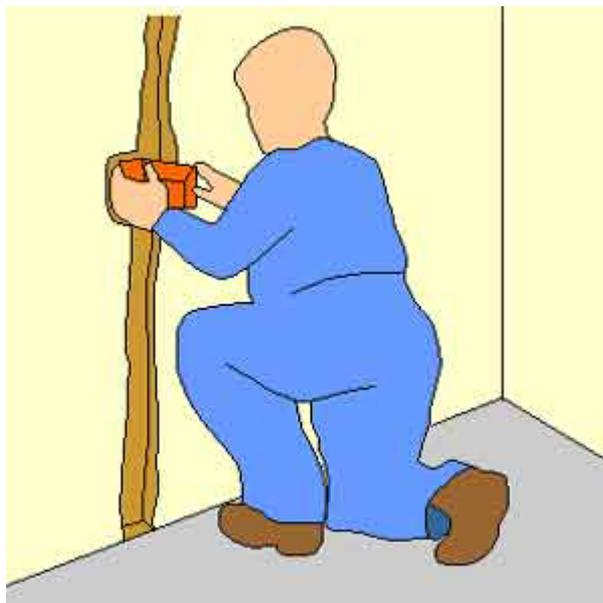
Fig.1.3: Si posizionano e si fissano saldamente con malta cementizia le scatole e le cassette di derivazione nella parete
